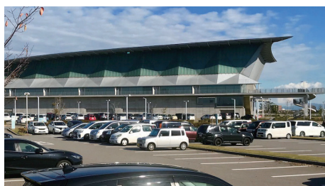
いしかわ総合スポーツセンター
